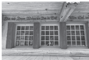
umbau haus in trueb
